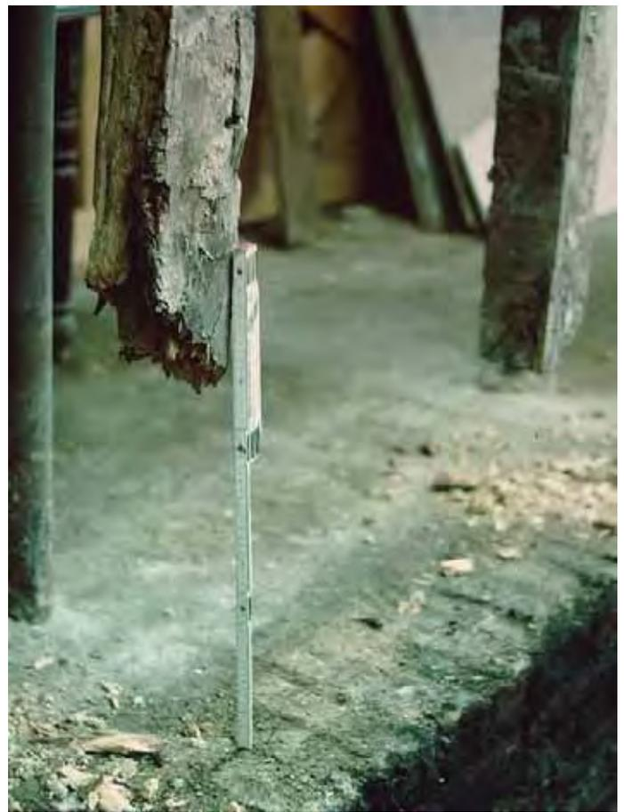
Abb. 3 Fundament mit verrotteten Fachwerkstielen am Westgiebel des Gebäudes
